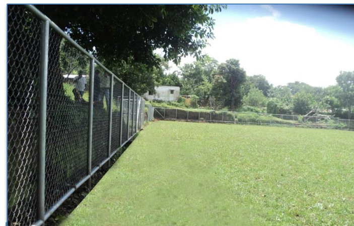
REMDELACIÓN DE CANCHA DE FÚTBOL EN EL CANTÓN SAN ANDRÉS, CIUDAD ARCE, LA LIBERTAD. $47,545.00
