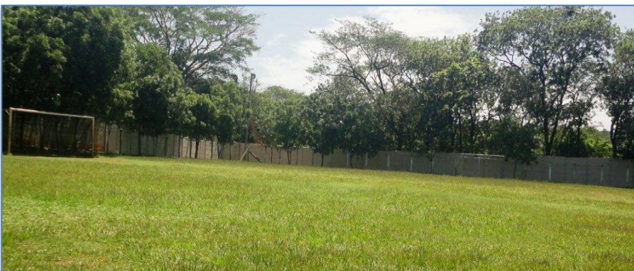
CONSTRUCCIÓN DE TAPIAL PREFABRICADO EN ESTADIO PASAQUINA DE LA UNIÓN. $29, 175.00
