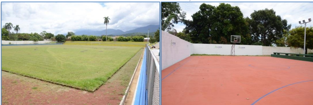
REMDELACIÓN E ILUMINACIÓN DE CANCHAS DEPORTIVAS Y ÁREAS DE CIRCULACIÓN DEL ESTADIO EL PROGRESO, EN CHALCHUAPA, SANTA ANA. $39, 150.98
