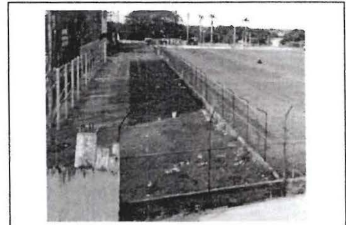
012 Desmontaje de malla ciclon perimetral existente del costado oriente.
