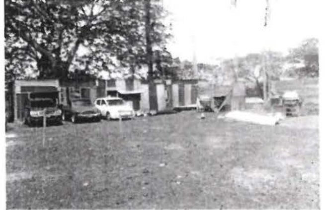
026 Hechura y construccion de bodega para las instalaciones provicionales
