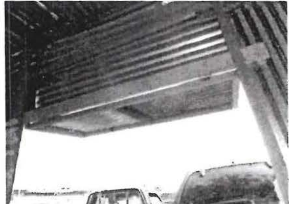
028 ventilacion apropiada para las instalaciones provicionales
