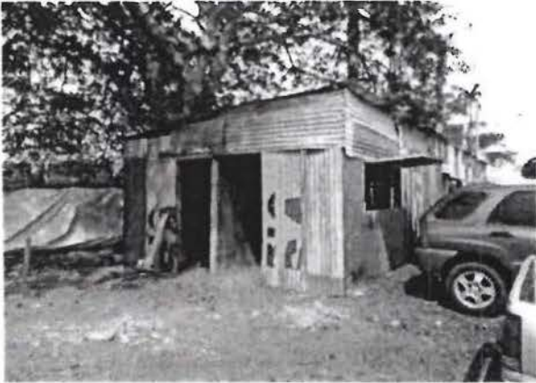
025 Hechura y construccion de oficinas para las instalaciones provicionales
