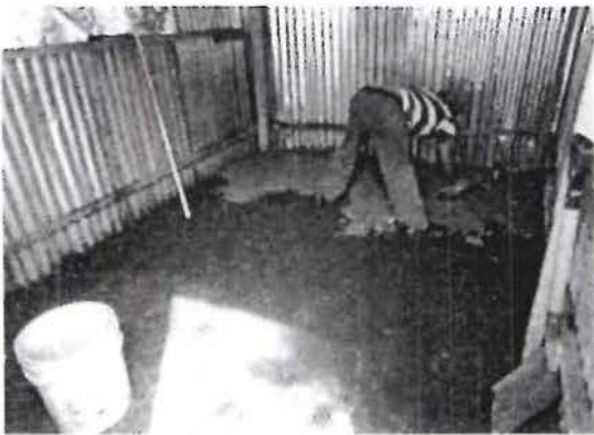
027 adecuacion del suelo para oficinas en las instalaciones provicionales
