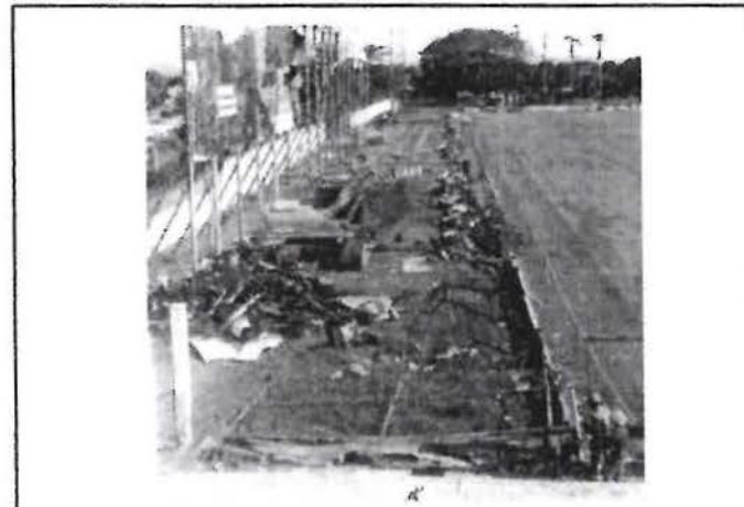
011 Desmontaje de malla ciclon perimetral existente del costado oriente.
