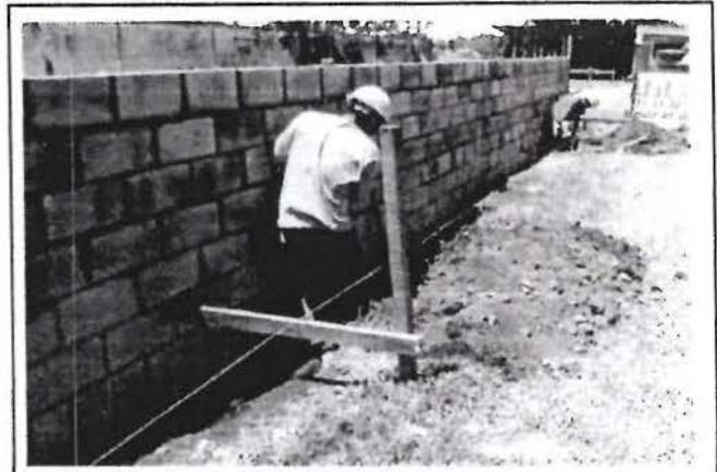
066 Cseguimiento dela colocacion de manposteria de bloque de concreto 10x20x40 en muro perimetral de eje1A
