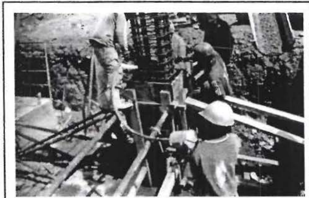
059 Vibrado de concreto F'C 210 kg/cm 2 en pedestal de columna tipo C-3 en eje 2
