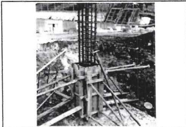
057 Hechura de molde para pedestal de columna tipo C-3 en eje 7
