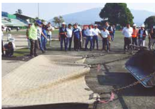
Las remodelaciones del estadio Las Delicias consisten en la colocación de grama sintética certificada por FIFA, e instalación de dos porterías de aluminio.
