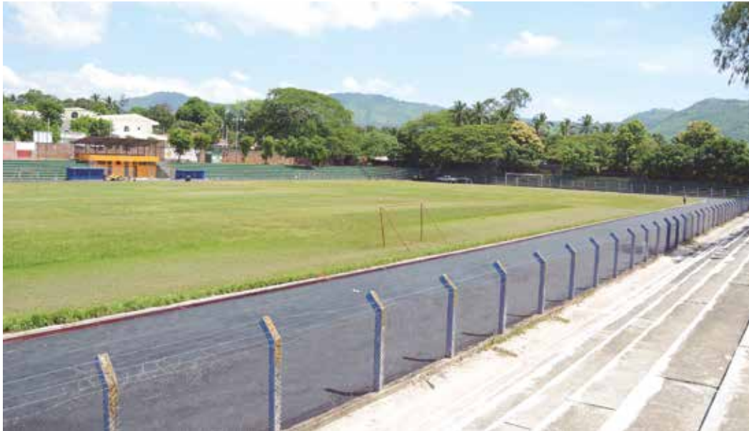
En el estadio de San Vicente se construyó un pozo para extracción de agua potable.
