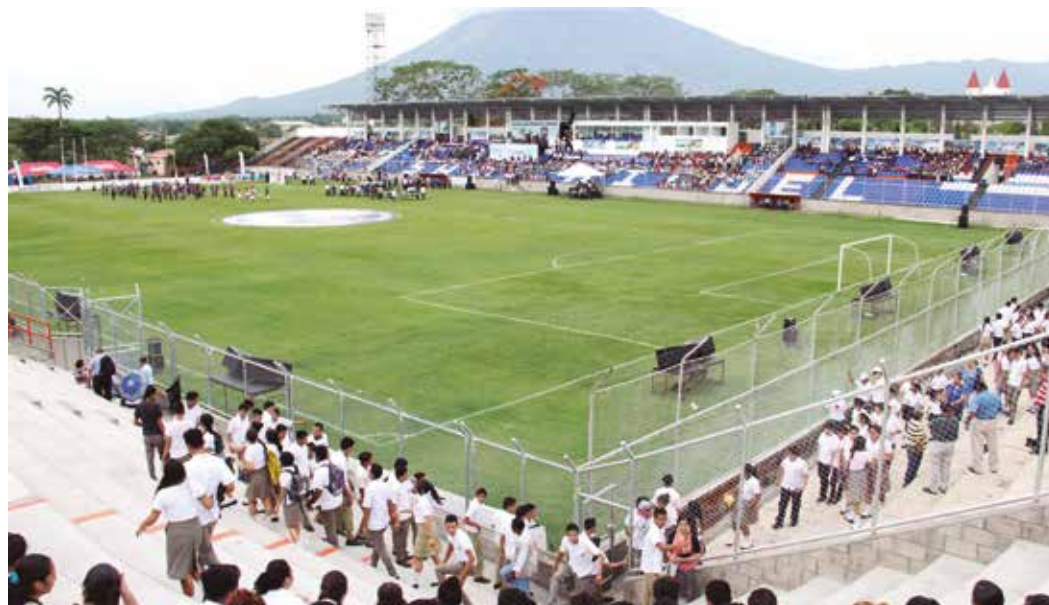
Los trabajos de la primera etapa del estadio Juan Francisco Barraza, de San Miguel, fueron entregados en 2017.
