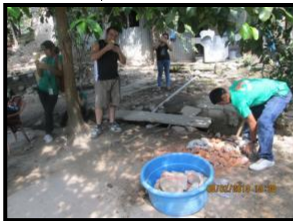
Mejicanos, Comunidad Santa Luisa Manejo de aguas servidas. arreglo de calles, mural, compostaje.
