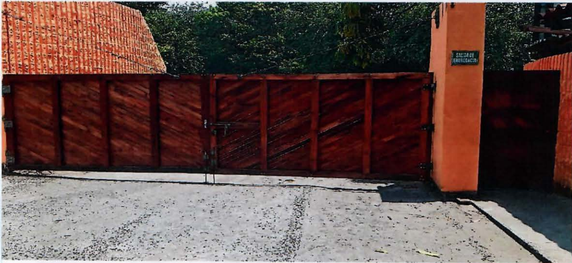
Reparación de portón
