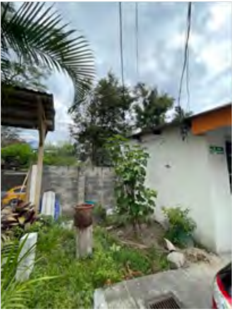
Antes: bodega insumos UACI
