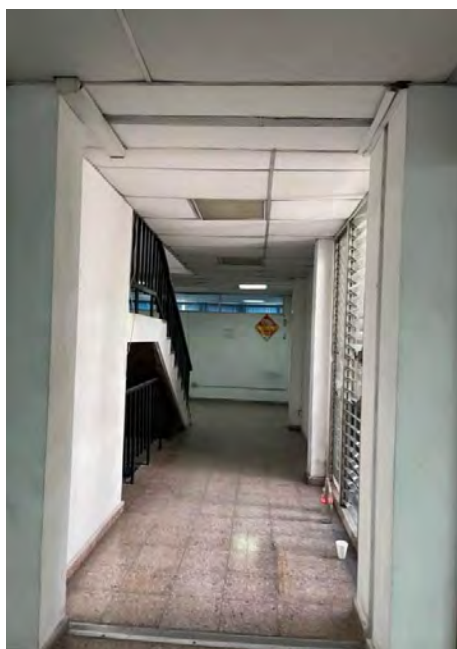
Antes: vista de pasillos.
