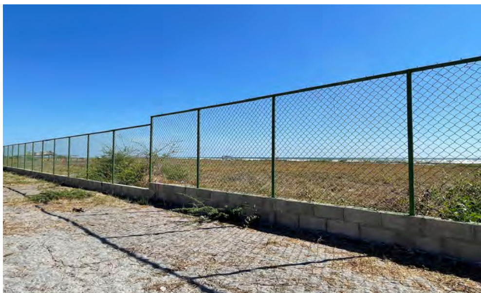
Después: Construcción de cimentación y muro bajo de bloque de concreto, reemplazo de tubos estructurales y malla ciclón.
