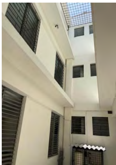
Antes: Vistas de patios internos.
