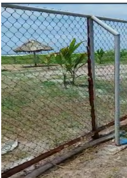
Antes: Barda perimetral antigua e imagen de barda desmontada donde se observa el daño a causa del salitre.
