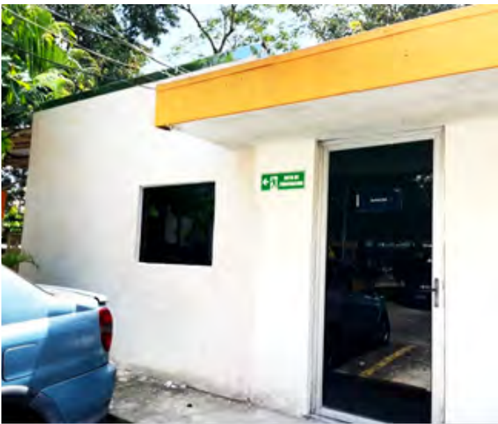
Después: ampliación de bodega de insumos UACI
