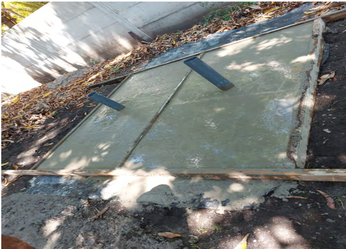
Construcción de fosa séptica en estero de Jaltepeque.
