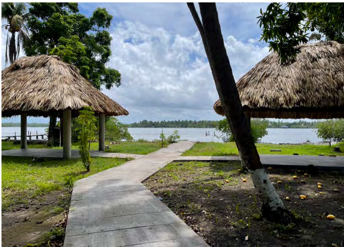
Construcción de 2 glorietas y senderos.
