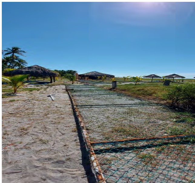
Antes: Barda perimetral antigua e imagen de barda desmontada donde se observa el daño a causa del salitre.
