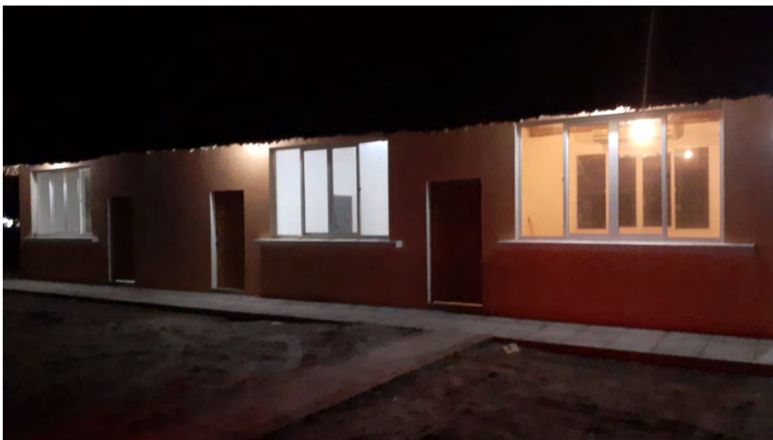
Habilitación de energía eléctrica e instalación de luminarias exteriores en Estero
