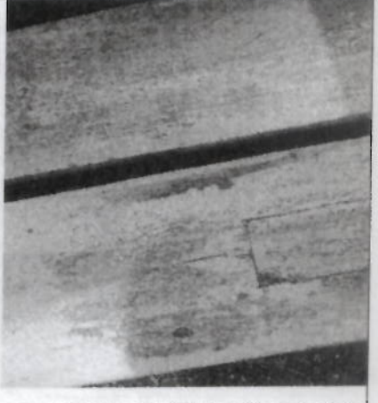
PISO DE SERVICIO SANITARIO DESNIVELADO EL AGUA EN DIFERENTE DIRECCIONES MENOS AL RESUMIDERO
