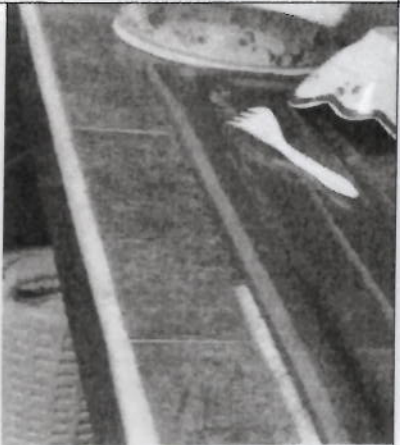
LAVASTASTOS CON FALTA DE CEMENTO EN EL BORDE
