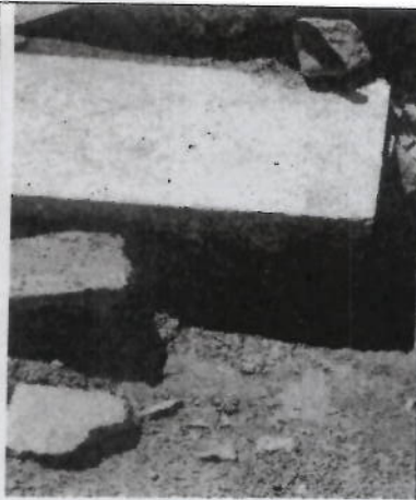
PRIMERA GRADA EROSIONADA EN LA PARTE DE ABAJO
