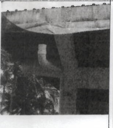
DETALLE DEL CANAL QUE FUE COLAPSADO POR TENER PASO DE AGUA MUY REDUCIDO Y FASCIA
