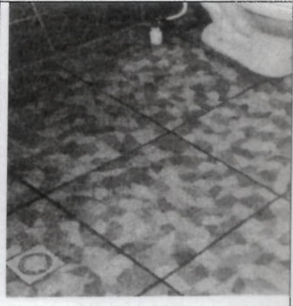
PISO DE SERVICIO SANITARIO DESNIVELADO EL AGUA EN DIFERENTE DIRECCIONES MENOS AL RESUMIDERO
