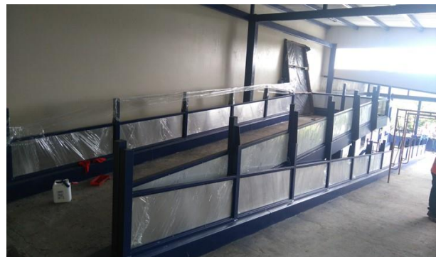
Mejoramiento de rampa para salida de emergencia
