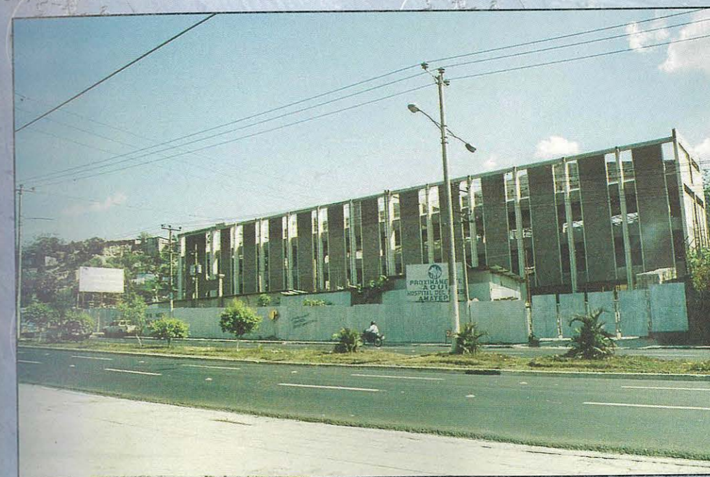
Readequación y Equipamiento Instalaciones de Hospital Amatepec
