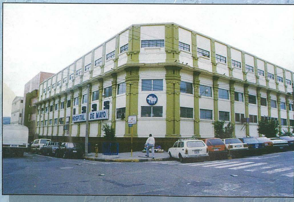
Techado y Reacondicionamiento de Loza Hospital 1° de Mayo
