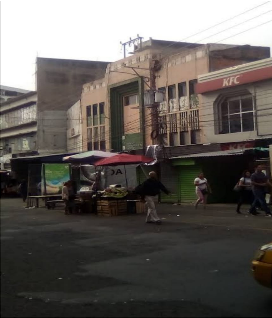
2-FACHADA DE EDIFICIO ISTU RUBEN DARIO CON VENTAS
