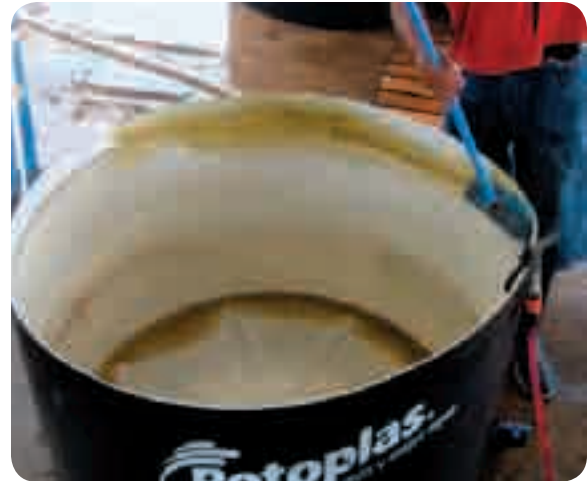
Fig. 3 limpieza manual de tanques de 500 L
