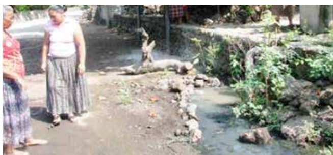
Condiciones de insalubridad ante manejo inadecuado de aguas residuales.
