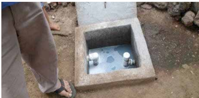
Construcción de módulos de captación de aguas residuales.
