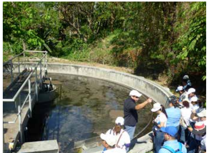
Planta de tratamiento de aguas residuales en Residencial Montemar, Colón, La Libertad.
