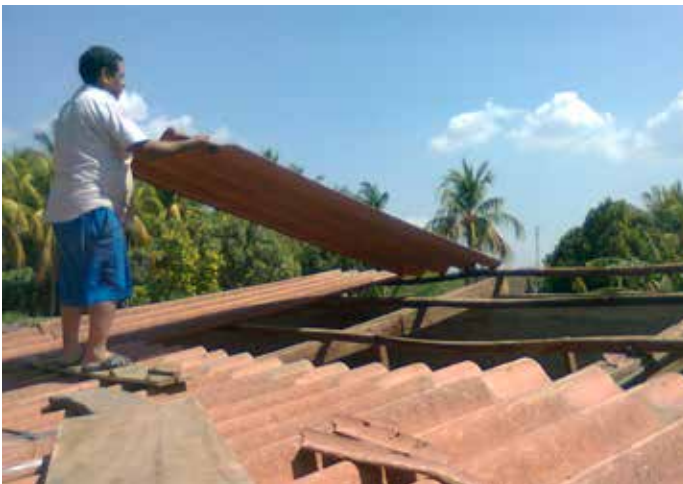
Obras de mejora realizadas en instalaciones de ANP en Puerto Parada
