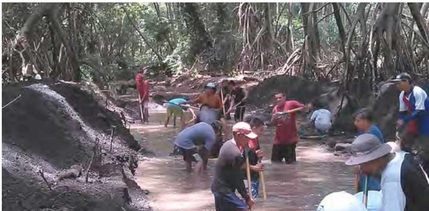
Integrantes de los comités de asesores locales, realizan trabajo de desazolve
