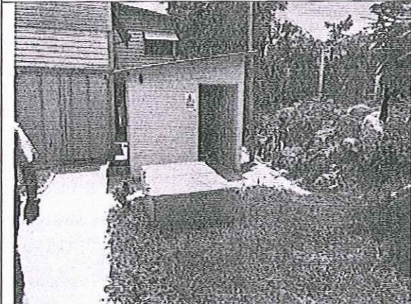
Fotografía 13. Pozo norte, ubicado en el área de oficina y servicios sanitarios.
