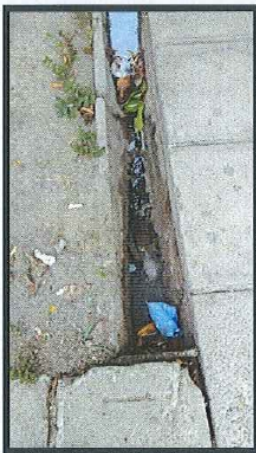
Ilustración 2. Canaletas de aguas pluviales con descarga de aguas residuales.
