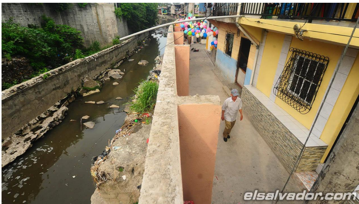
Figura 29: Fotografía de la infraestructura construida en las márgenes del arenal Tutunichapa (Jun 02, 2015- 09:31)
