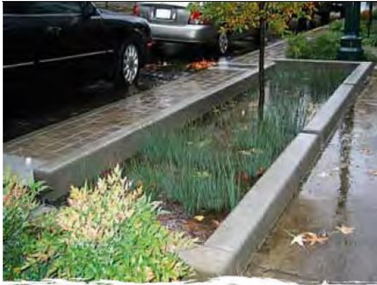
Figura 58: Áreas de bioretención en Portland, Oregon, USA. Foto: Dusty Gedge. Fuente: Graham et al. (2012)
