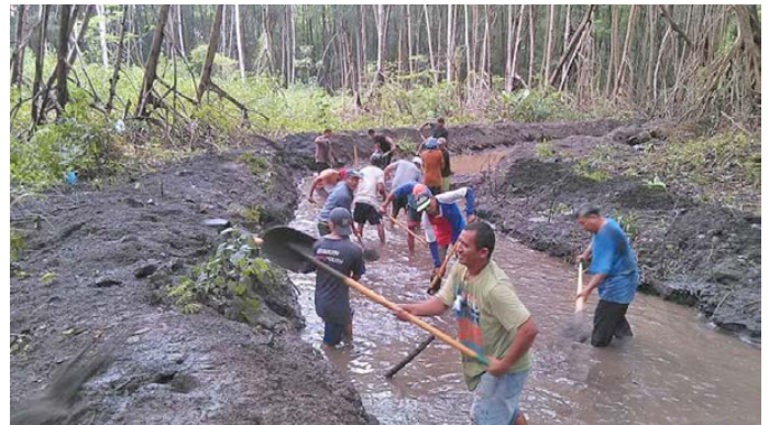
Como parte de la restauración ecológica del bosque salado habitantes, de las comunidades realizan desazolve de los canales de los manglares.
