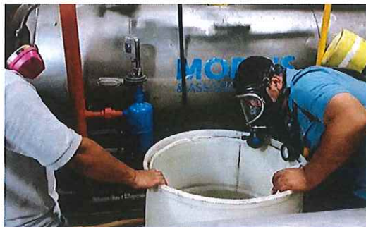
Foto 2: Personal de la empresa realizando extracción controlada del amoníaco remanente en las tuberías del sistema de refrigeración.
