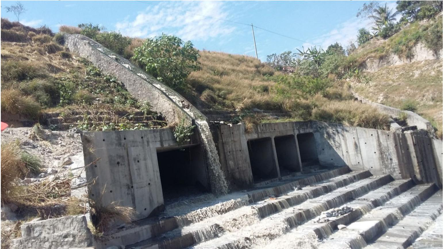
Imagen de la descarga del Colector Secundario Soyapango, desembocando en la cuenca baja del río Sumpa
