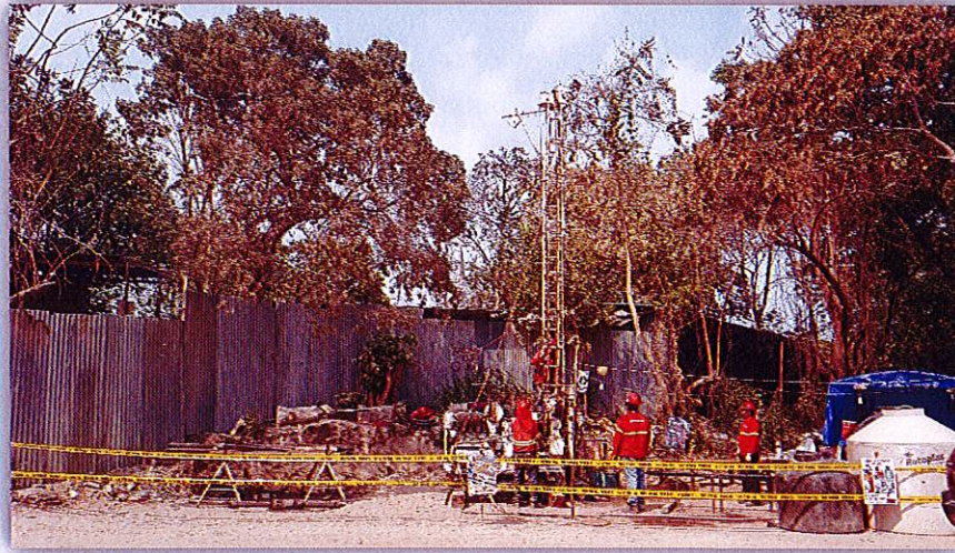
Sondeo R-02 atrás se observan instalaciones provisionales de la construcción contigua.
