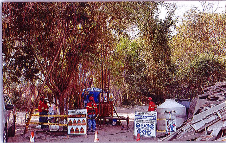
Sondeo R-03 ubicado en la parte media del terreno
