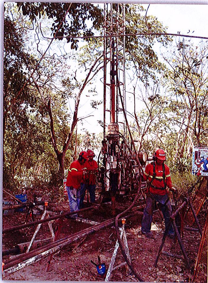
Sondeo R-07 ubicado en zona cercana a Calle El Pedregal.
