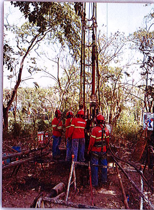
Sondeo R-05 ubicado en zona cercana a Calle El Pedregal.
