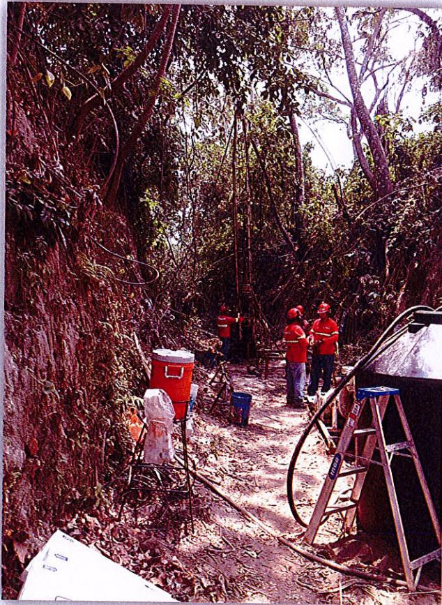
Sondeo R-06 ubicado en zona interna de quebrada existente.
