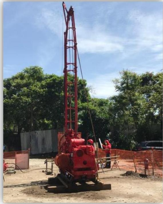
*Fotografías mostrando equipo de Rotativa Long-Year 38 utilizada para la perforación y determinación de permeabilidad (k)*
