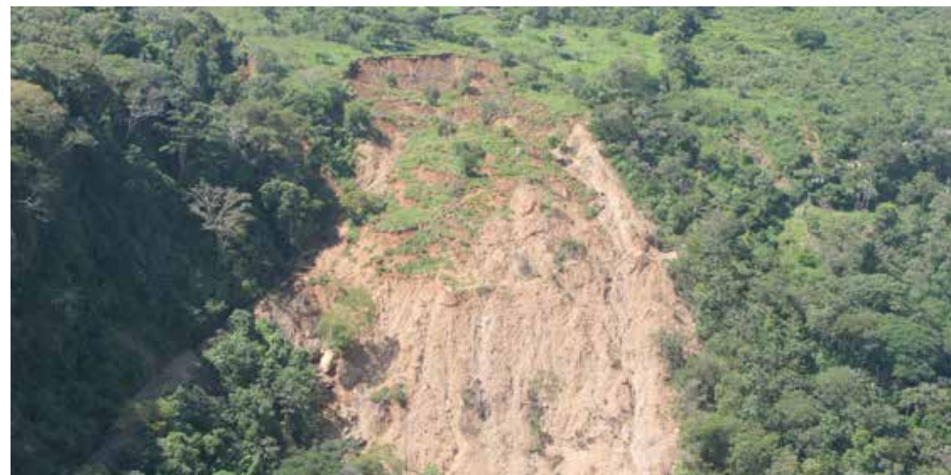
Figura 6. Deslizamiento, caserío El Camalote, municipio El Carrizal, Chalatenango. Octubre 2011
