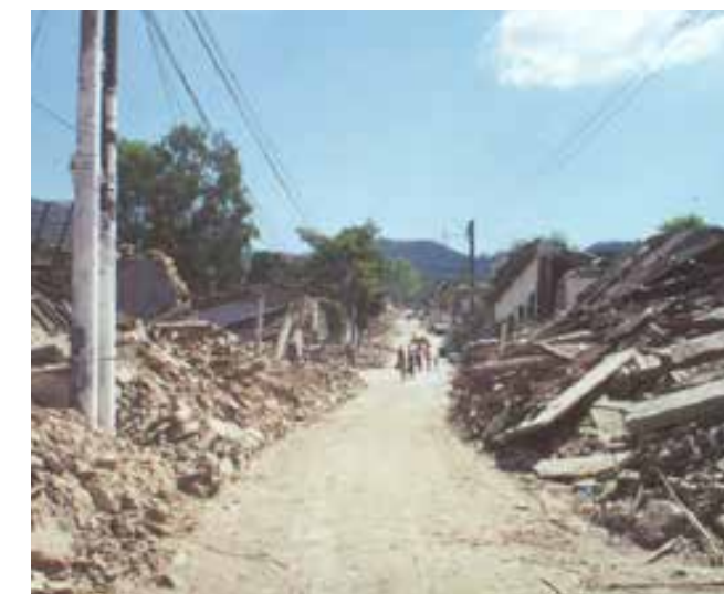
Figura 131. Daños observados durante los sismos del 2001 60 Fuente: Earthquake Engineering Research Institute, 2001 M 7.7 & M 6.6 El Salvador Series
