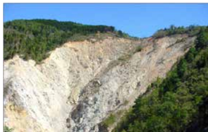
Figura 56: Deslizamiento la Zompopera, Chalatenango, activado en 1998 Fuente: MARN
