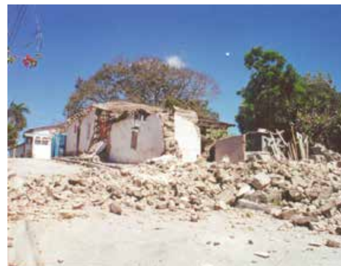
Figura 130. Daños observados durante los sismos del 2001 60 Fuente: Earthquake Engineering Research Institute, 2001 M 7.7 & M 6.6 El Salvador Series
