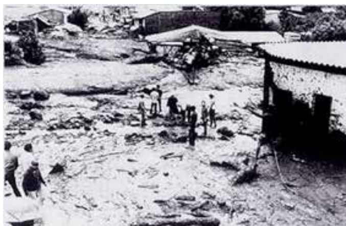
Figura 54: Viviendas afectadas por flujo de escombros (deslave) originado en El Picacho y que afectó Montebello en septiembre de 1982. Fuente: elsalvador.com
