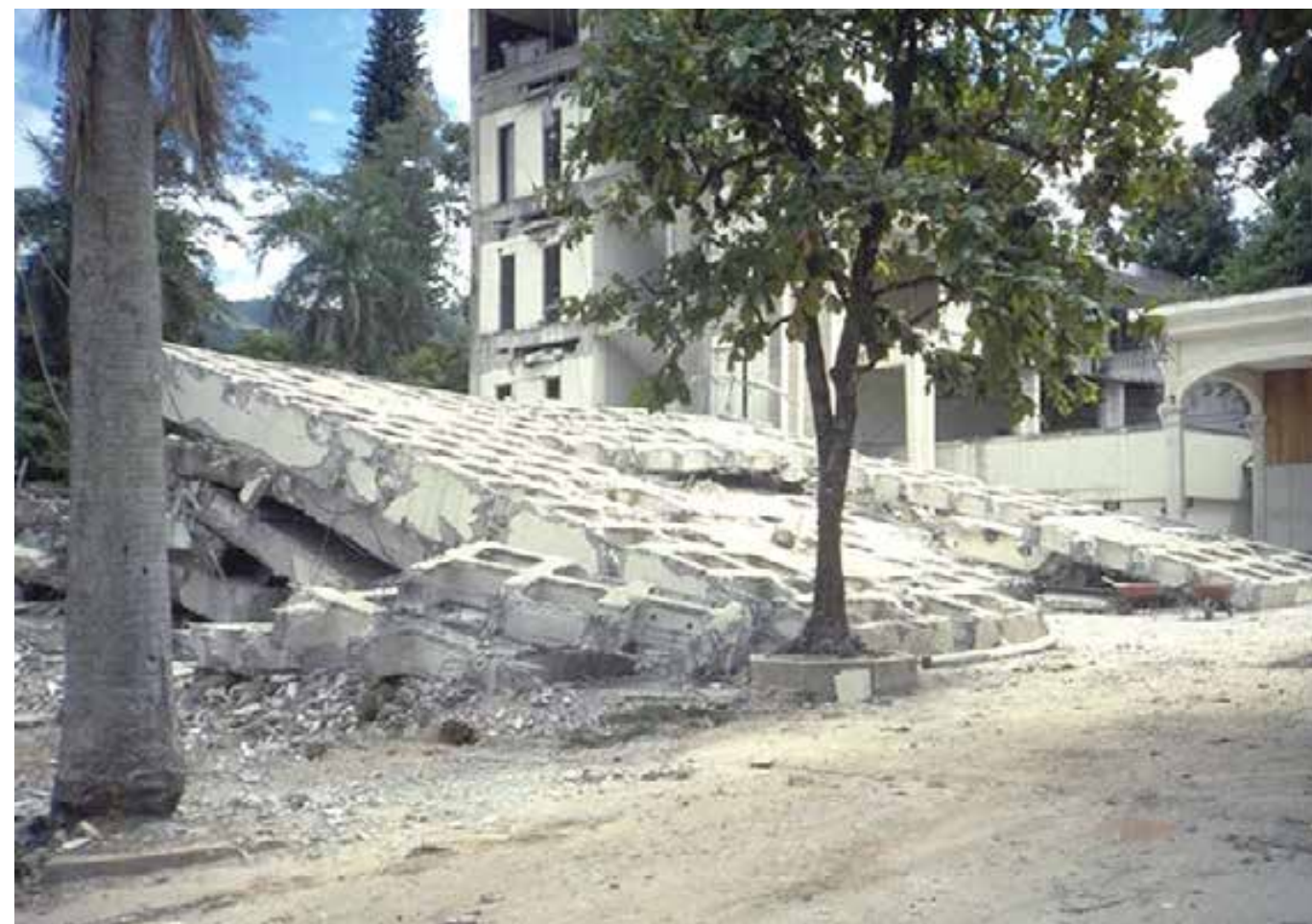
Figura 132. Daños observados durante el sismo de 1986, M5.7 – San Salvador Fuente: Earthquake Engineering Research Institute, 2001 M 7.7 & M 6.6 El Salvador Series
