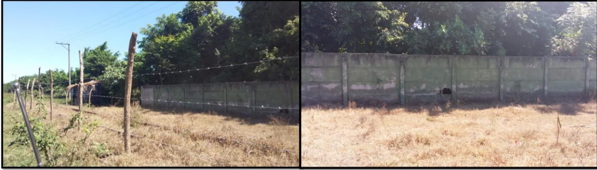
Figura 26. Cercado en la zona de monitoreo de los drenajes de BAES (Diciembre 2015).
