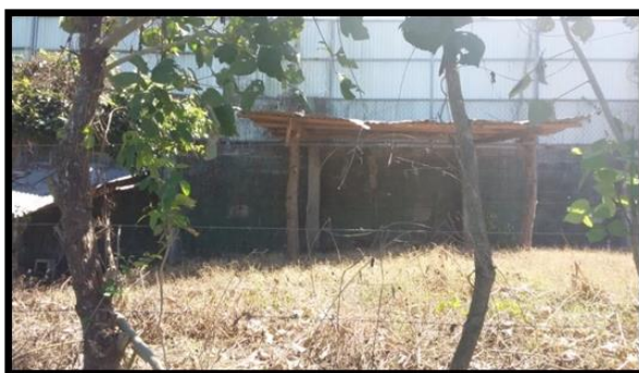
Figura 18. Chozas de madera y lámina instaladas en la zona de drenajes de BAES (Diciembre 2015).
