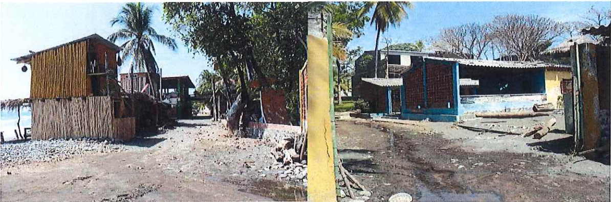
Fotografía #7: ranchos de dos niveles, paredes de vara de bambú, madera y techo de lámina; Fotografía #8: casas bloque de concreto y se muestra que las aguas residuales son derramadas directamente al suelo y estas conducidas al mar.
