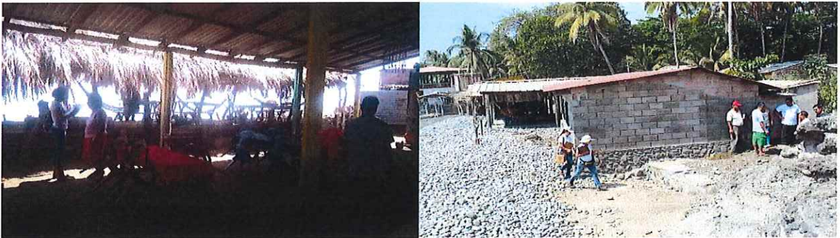
Fotografía #15: Muestra que estas construcciones son utilizadas como restaurantes, hostales para turistas y lugares de venta de artesanías; Fotografía #16: Fosa séptica de hostel a aproximadamente 20 metros del mar.
