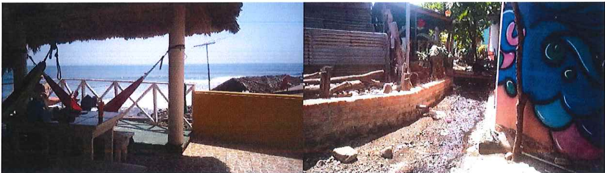
Fotografía #9 Vista desde el segundo nivel de una construcción, de bloque de concreto y piso cerámica, es utilizado el lugar como uso recreativo para turistas; Fotografía #10: Aguas residuales de las casas directamente derramadas al suelo, no poseen canaletas de aguas lluvias ni sistema de aguas residuales, estas se unen y son canalizadas al mar.
