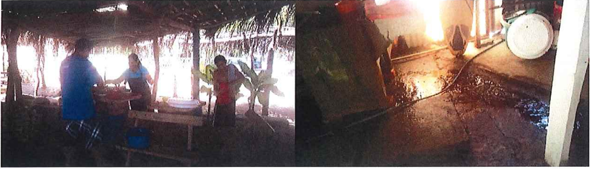
Fotografía #11: Rancho hecho de columnas de madera y techo vigas vara de bambú y palma, utilizado para venta de comida; Fotografía #12: pila dentro de casa que derrama aguas grises al piso.
