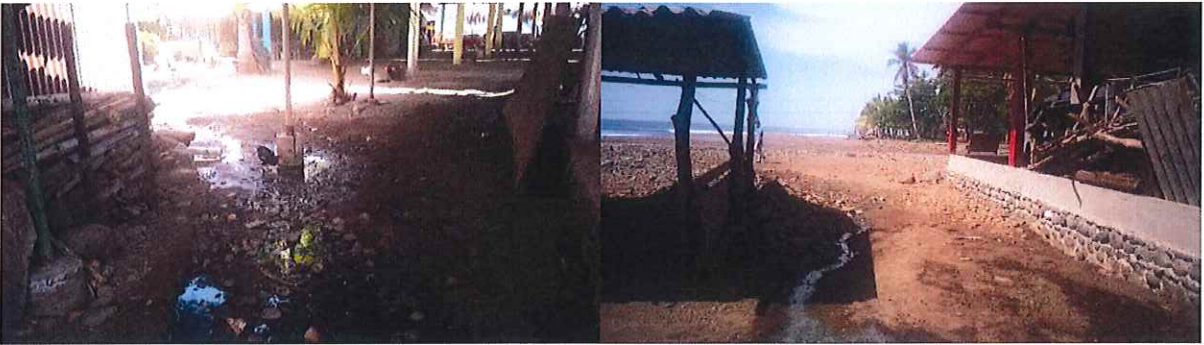
Fotografía #13 y #14: No poseen sistema de aguas grises ni aguas lluvias y se encuentran estas casas aproximadamente a 20 metros del mar, directamente son conducidas al mar, siendo un foco altamente contaminante.
