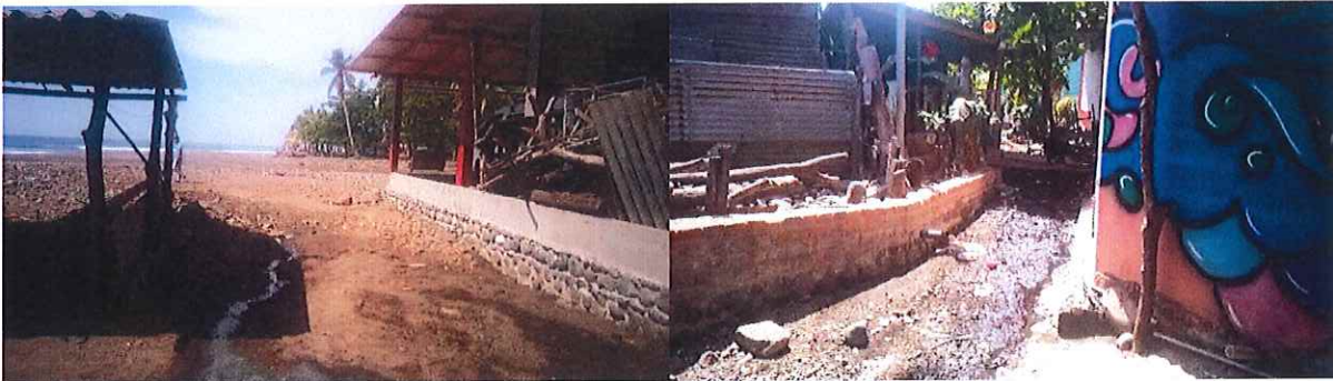
Fotografías # 17 y 18. Se observa como las aguas grises y lluvias, son conducidas por en medio de las viviendas asentadas dentro de la línea de playa, sin tratamiento alguno.
