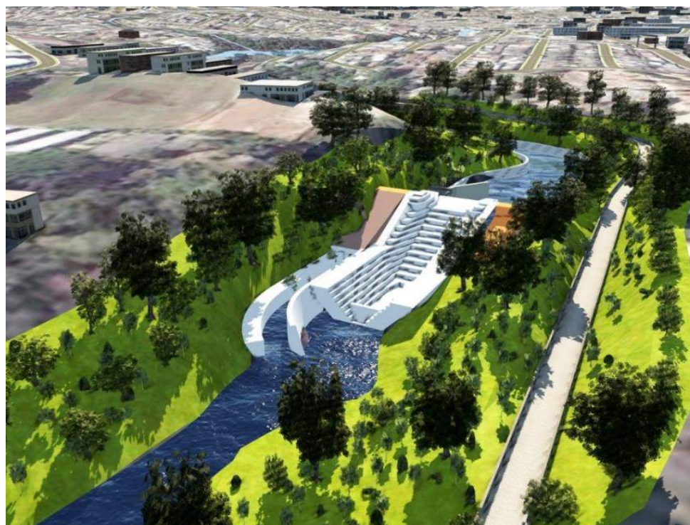
Figura 66. Laguna de laminación en construcción en el arenal de Monserrat del AMSS Fuente: https://goo.gl/LDeFxX
