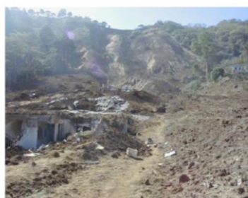
Fotografía 25. Deslizamiento en Colonia Las Colinas. Fuente: DGOA
