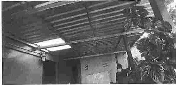
Fotografía 7. Area de cafetín techada.
