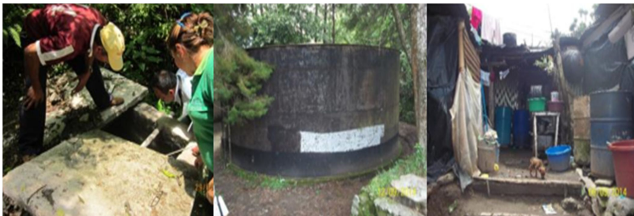
ILUSTRACIÓN 20: CAJAS DE CAPTACIÓN Y SISTEMAS DE ALMACENAMIENTO DEL AGUA LLUVIA EN RI.
