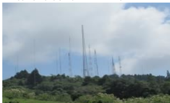
ILUSTRACIÓN 43: RED DE ANTENAS DE RADIO Y TELECOMUNICACIONES EN PERÍMETRO DEL ANP
