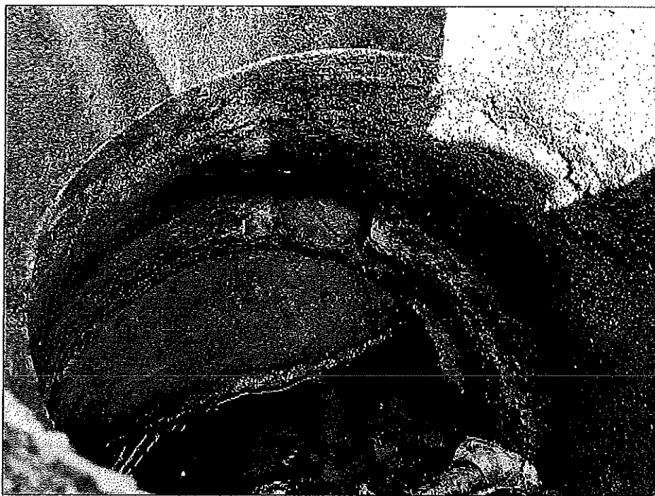
Figura 5. Pozo con agujero de trasvase tapado.
