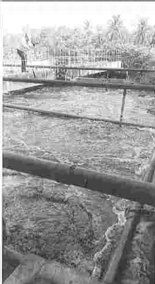
Fig. 3 Tanque de Aireación del sistema de tratamiento
