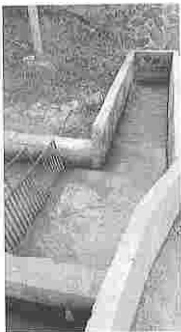
Fig. 1 Entrada de Aguas residuales de la PTAR Chilama provenientes del pozo de bombeo
