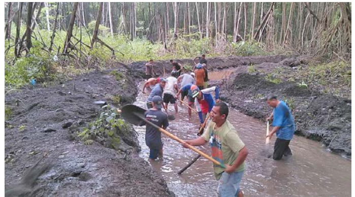
Como parte de la restauración ecológica del bosque salado habitantes, de las comunidades realizan desazolve de los canales de los manglares.
