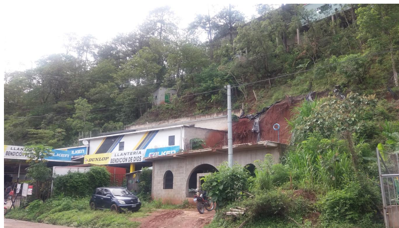
Edificaciones expuestas a la amenaza de deslizamientos en el municipio La Palma, departamento de Chalatenango
