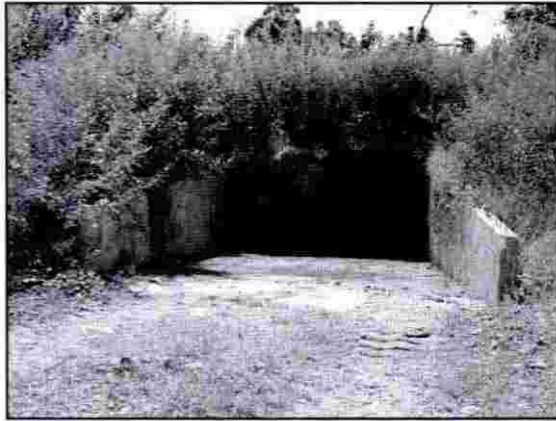
Fotografía 1. Acondicionamiento de sitio de acopio de desechos sólidos.
