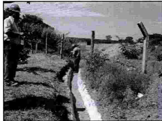
Fotografía 4. Canaleta de descarga de pozo sedimentador que al final de la canaleta no posee gradas de descarga.
