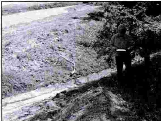
Fotografía 3. Borda construida en vez de la acequia a orillas del río Jiboa y canaleta intermedia, ubicada afuera de los límites señalados por el cercado del inmueble.
