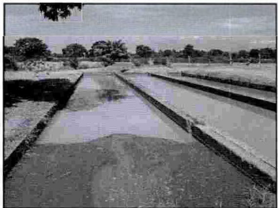
Fotografía 8. Pilas o pozo sedimentador.
