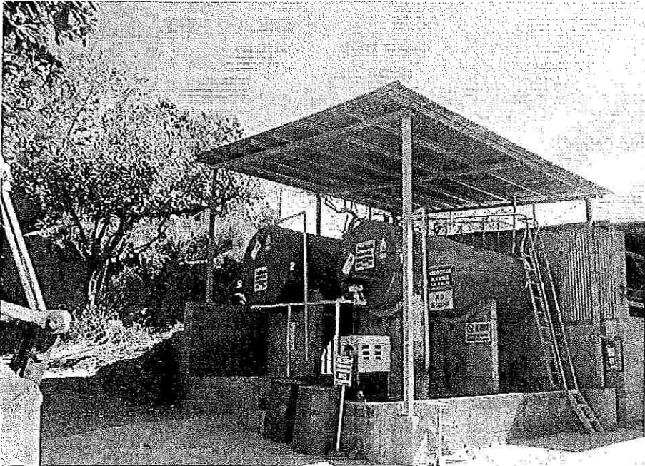
Fotografía 2. Berma construida para tanques existentes de diesel
