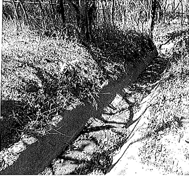
Fotografía 14 Canaleta que cuenta con diferencia de nivel a la salida del sistema de pozos de sedimentación, esta presenta humedad en el fondo.
