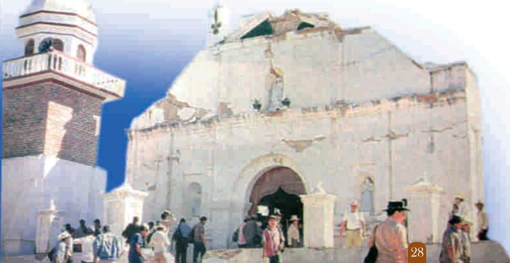
Iglesia de Santa María Ostuma. Terremoto del 2001
