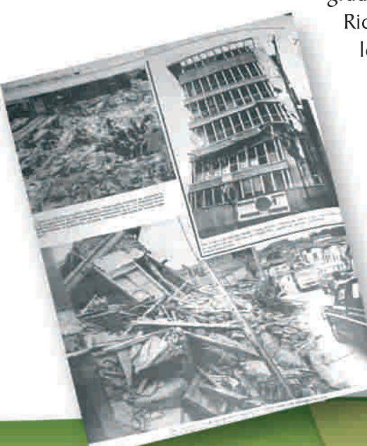
Imágenes LPG. Terremoto 10 de septiembre 1986
