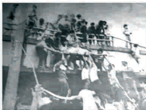
Edificio colapsado en el centro de S.S., terremoto 10 de octubre de 1986
