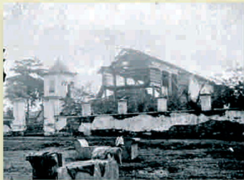
Iglesia de Quezaltepeque. Terremoto 1917
