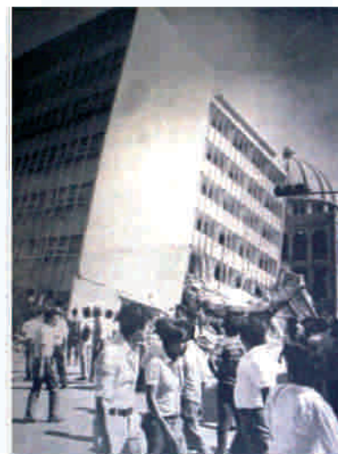
Hotel El Salvador colapsado, terremoto 10 de octubre de 1986
