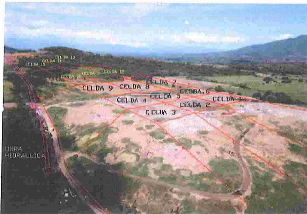
Imagen 8: Celdas en funcionamiento, Fase 1, y Fase 2, y obra hidráulica.
