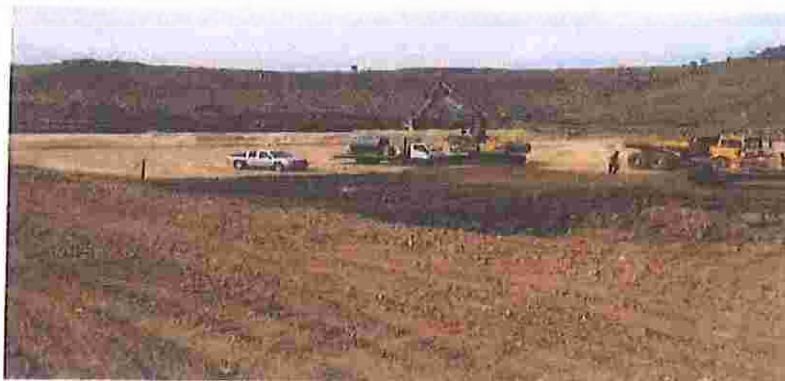
Imagen 3: Ilustración de proceso de terracería.
