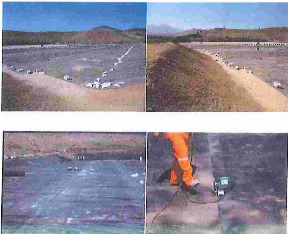
Ilustración 10. Proceso de instalación de geomembrana.
