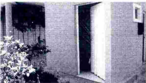
Contenedor de desechos sólidos
