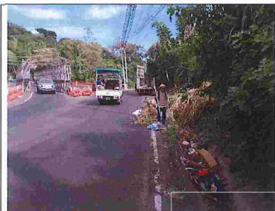
Fotografía 7. Limpieza de drenajes en calle Agua Caliente, con personal del MARN.
