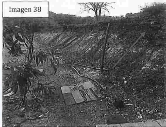
Imagen 38. Corte realizado, para extracción material e incorporarlo en los alrededores inmueble.
