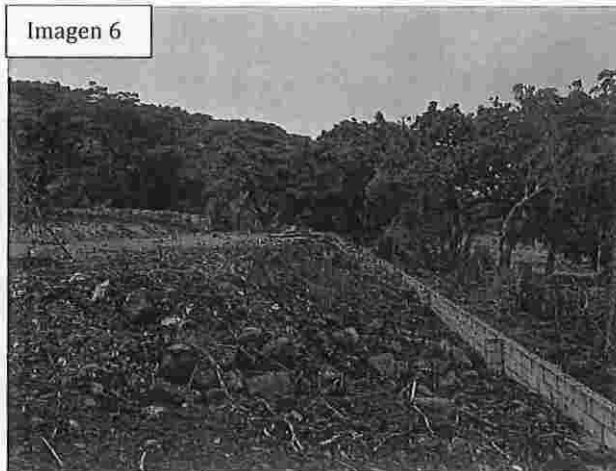
Imagen 6: Vista del inmueble intervenido, con terracería y relleno, hacia muro en construcción.
