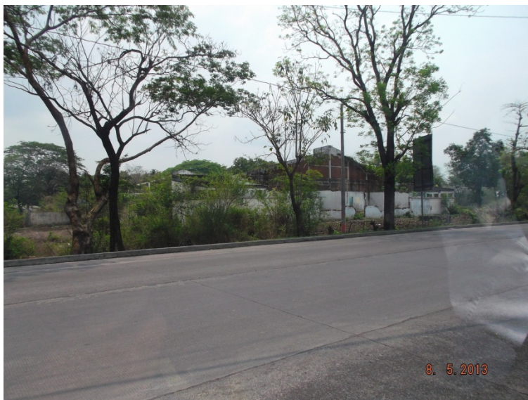
Figura 79. Almacén abandonado donde se depositaron los barriles con toxafeno.
