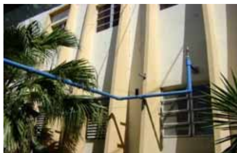
Cambio de la red de tubería de agua potable
