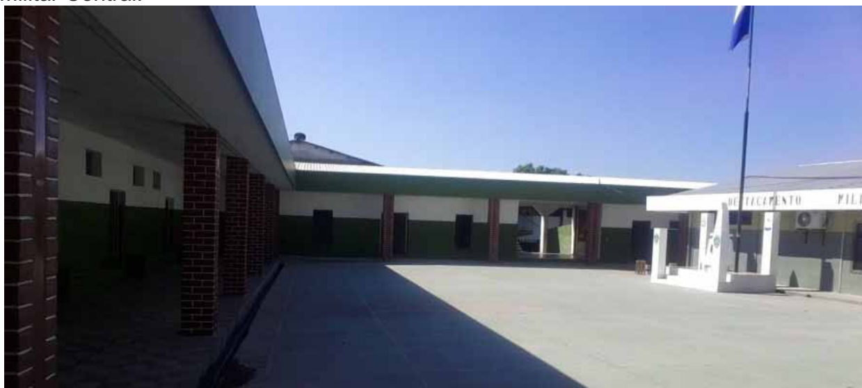
Fachada del techo e instalaciones del Destacamento Militar No. 9.
