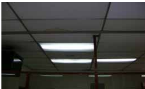
Reparación techo en el HMC
