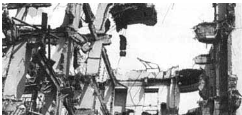
▶ Edificios de la Colonia Zacamil dañados por el terremoto de 1986.
