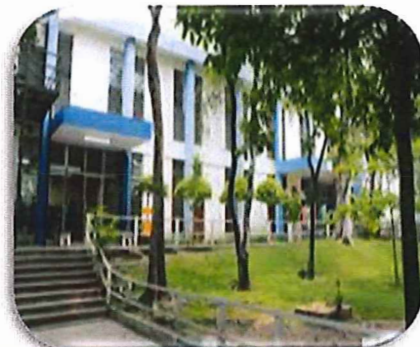
Edificio ITCA FEPADE/ Ministerio de Educación Entre 1987-1995
