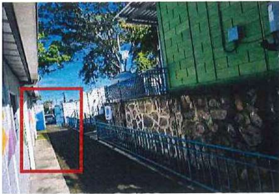
Acceso con puerta al Exterior por el CFL de la Alcaldía Municipal de Santa Tecla
