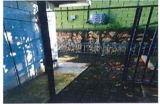
Evidencia de puerta abierta
