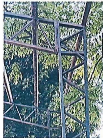
VISTA DE ESTRUCTURA METALICA DE COLUMNA METALICA CM1, QUE NO SE LE COLOCO VIGA VM NI POIN P-1 6", ESTO IMPLICA UN RIESGO, POR NO TENER RIGIDEZ ATRAVES DEL MARCO DE LA VIGA
