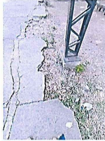
VISTA DE PEDESTALES Y PLACAS METALICAS QUE SOLORTAN LA COLUMNA METALICA CM1, SE OBSERVA EL PISO CON UN DAÑO MAYOR
