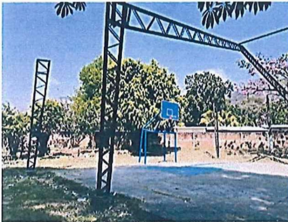
VISTA DE ESTRUCTURA METALICA DE COLUMNA METALICA CM1, QUE NO SE LE COLOCO VIGA VM NI POIN P-1 6", ESTO IMPLICA UN RIESGO, POR NO TENER RIGIDEZ ATRAVES DEL MARCO DE LA VIGA
