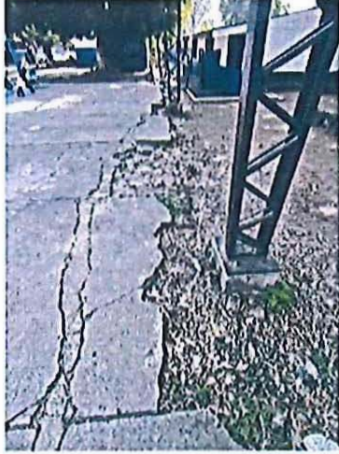
VISTA DE PEDESTALES Y PLACAS METALICAS QUE SOLORTAN LA COLUMNA METALICA CM1, SE OBSERVA EL PISO CON UN DAÑO MAYOR
