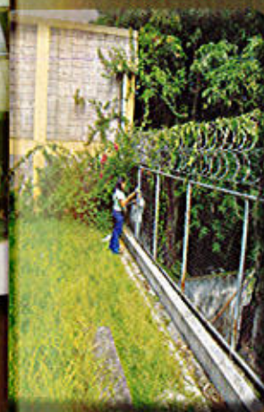
Supervisión de trabajos de cerca electrificada.
