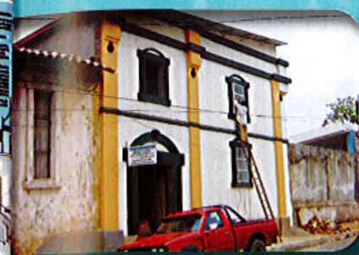
Restauración en Clínica San Francisco, San Miguel.
