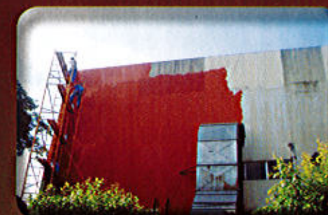
Trabajos de pintura
