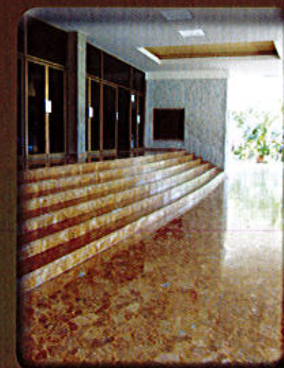
Restauración de pisos de mármol
