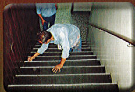
Reparación de gradas.
