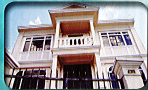
Restauración en 17 Av. Sur de San Salvador.
