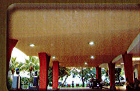
Trabajos de iluminación en entrada principal
