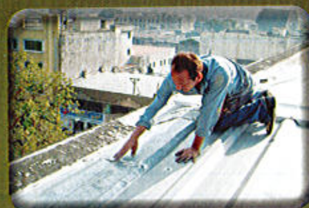
Reparación de techos.
