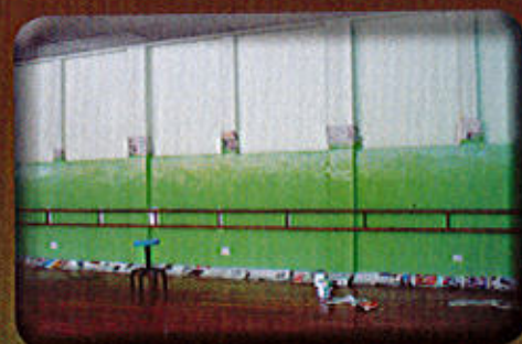
Trabajos de pintura
