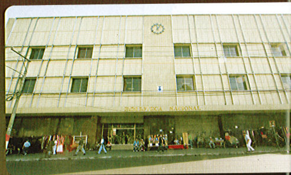
Trabajos de pintura en fachada e interiores del edificio.
