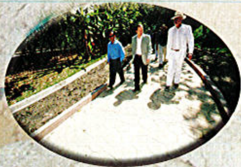
Trabajos de mejoramiento en sendas Joya de Cerén
