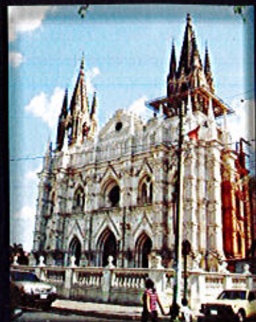
Restauración de Catedral de Santa Ana.
