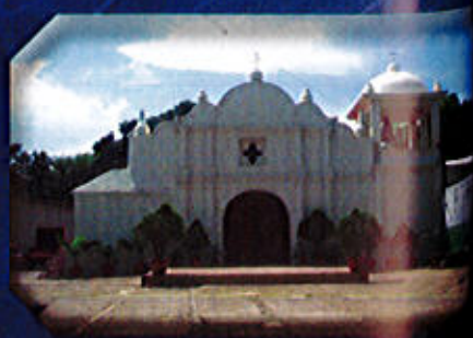
Restauración de Iglesia San Pedro y San Pablo en Calulhuet, Sonsonate.
