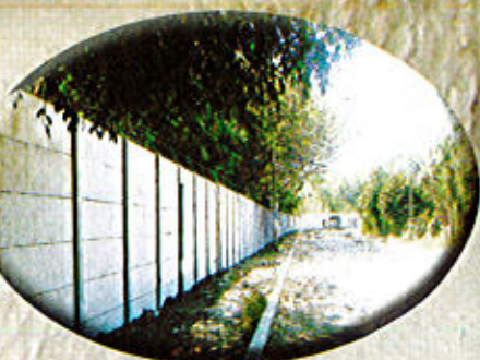
Muro Perimetral en Parque Arqueológico Joya de Cerén
