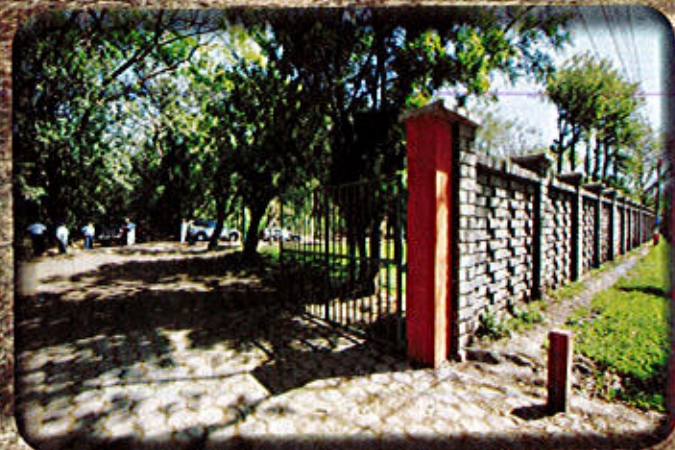
Muro Perimetral en Parque Arqueológico San Andrés
