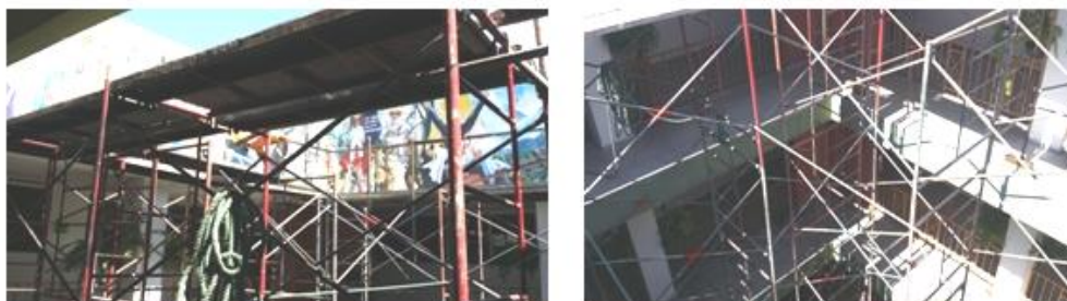
Instalación de andamios para restauración de mural interior del edificio A-5
