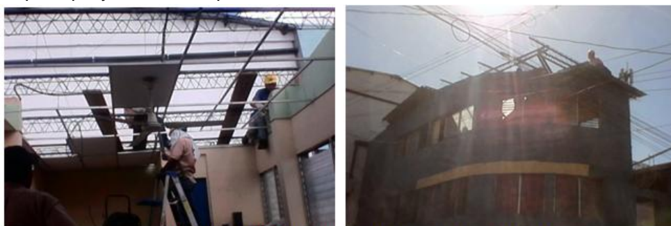
Reparaciones y cambio de techo en Casa de la Cultura de Chalatenango
