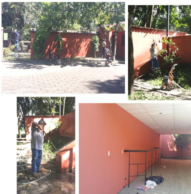
TRABAJOS DE MEJORA EN LAS INSTALACIONES DEL SITIO ARQUEOLOGICO SAN ANDRÉS
