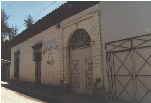
Detalle del zaguán con arco de medio punto y tímpano de hierro forjado, es enmarcado el vano por pilastras adosadas con textura de almohadillado, este se ubica sobre la fachada poniente
