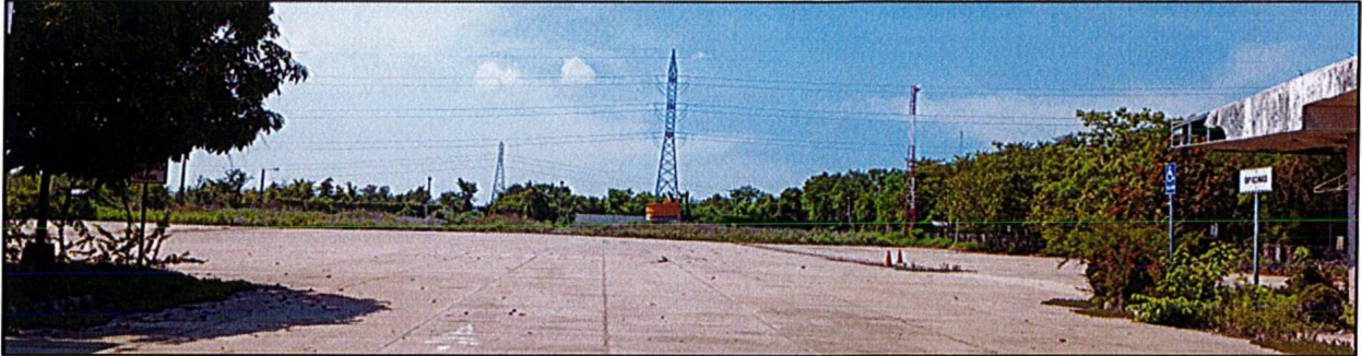
Imagen 6. Se muestran imágenes de otra porción que ocupará la línea férrea, tramo 2, km 0.5/0.6 aprox.
