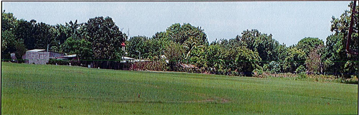
Imagen 11. Se muestran imágenes de otra porción que ocupará la línea férrea, tramo 18 km 17.5/17.7 aprox.
